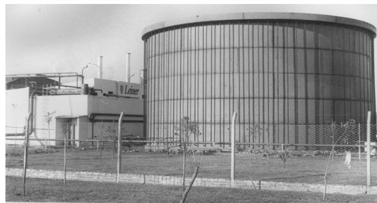
BP LEINER Gelatinas, Parque Industrial Sauce Viejo, Santa Fe, 1992. Biodigestor para tratar 3.120 m 3 efluentes/ día.
