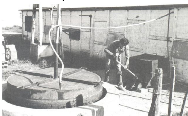
Biodigestores en tambos, Humboldt, Esperanza -Santa Fe años '60 y '70.
